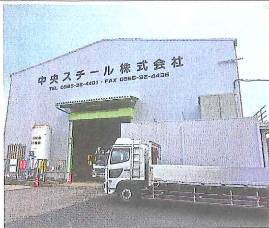
遮熱塗料を施工した工場棟
